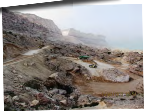
De V-vorm van de klif wordt dieper gemaakt en het materiaal naar beneden geschoven en dient als ondergrond voor de weg
