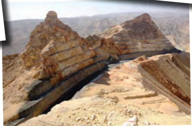
De uiteindelijke weg op dezelfde plaats, iedere afgegraven stap is 10 meter hoog
