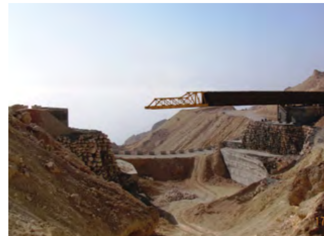
bouw van stalen brug
